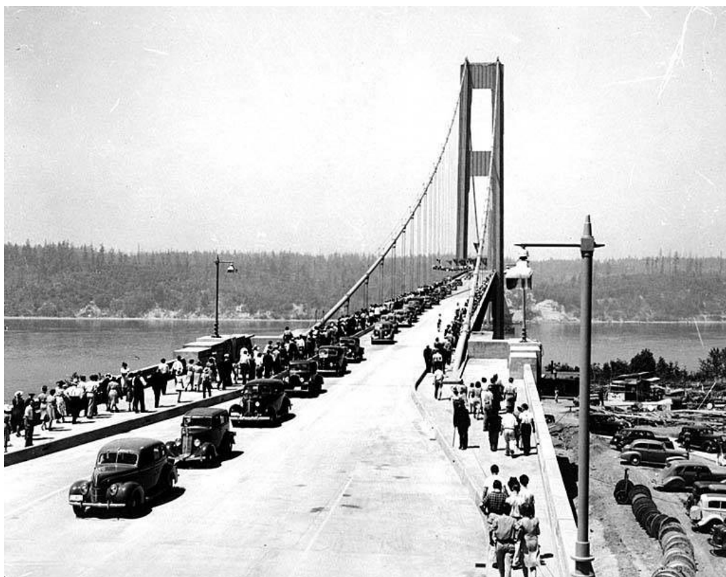
Obr. 1. Původní Tacoma Narrows Bridge z roku 1940. [1]
